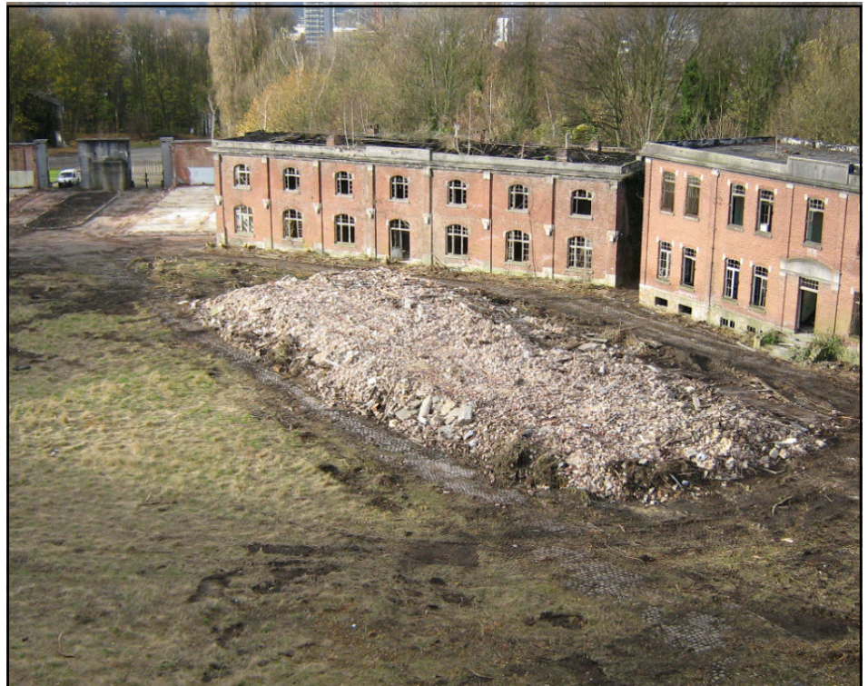
Le bâtiment des cachots, après sa démolition par Immo-Chartreuse.
