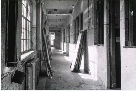
L'hôpital avant son aménagement (8)
