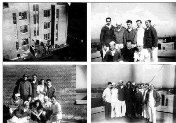
On pose sur le toit de l'hôpital de la Chartreuse (13)
