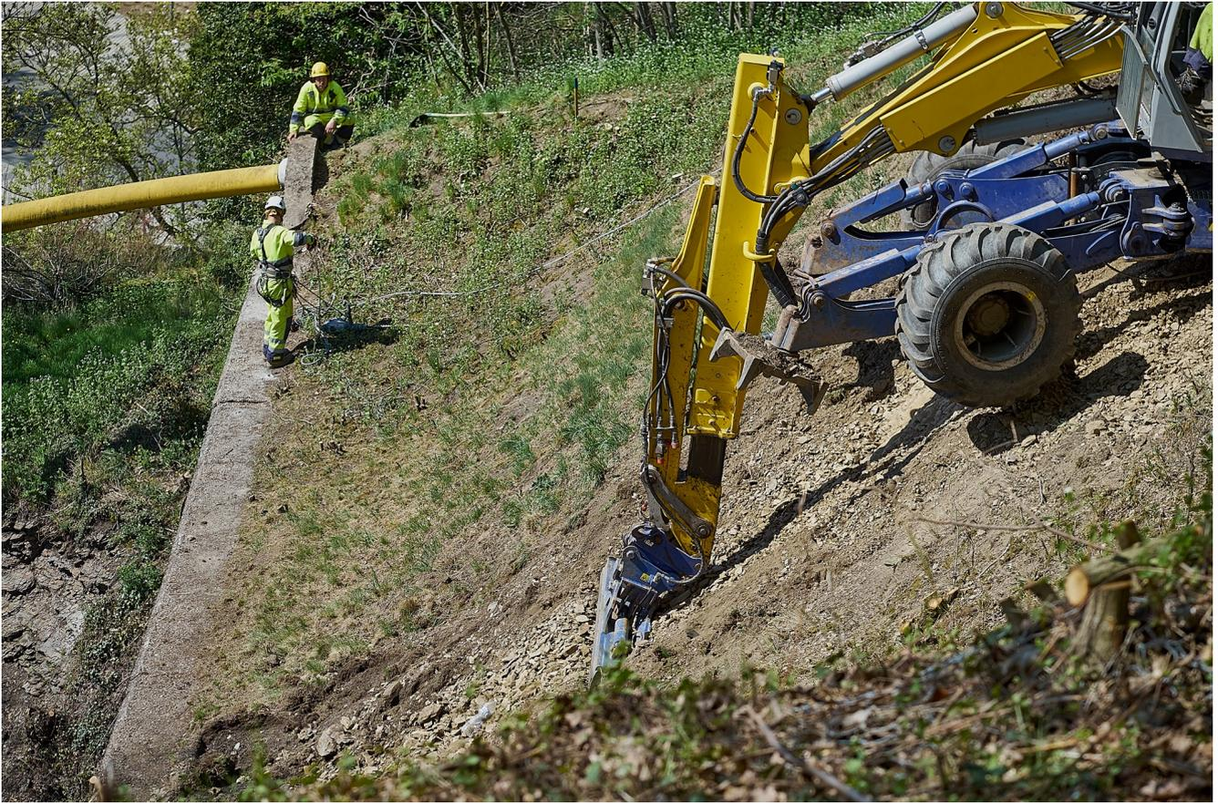
Photo 7: Dégagement des pierres au-dessus du tunnel.
